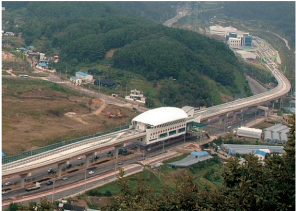
부산 3호선 2단계 328공구 토목공사 2004.04~2010.12
