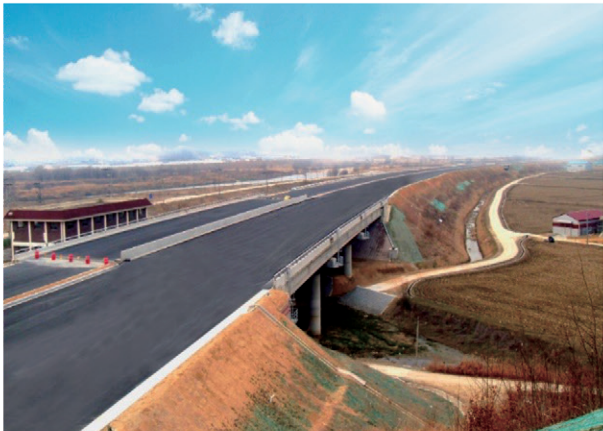
행복도시-고속철도 오송역 도로건설공사(1공구) 2008.12~2022.07
