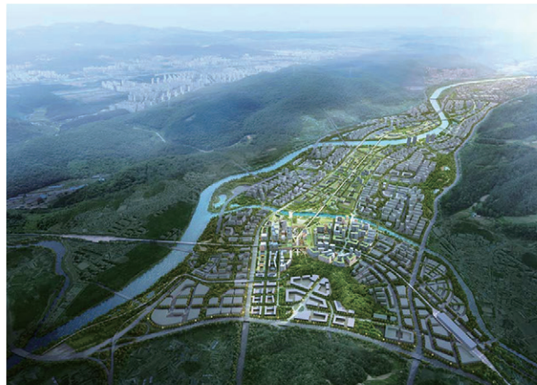
남양주왕숙 공공주택지구 조성공사(3공구) 2022.11~2028.06
