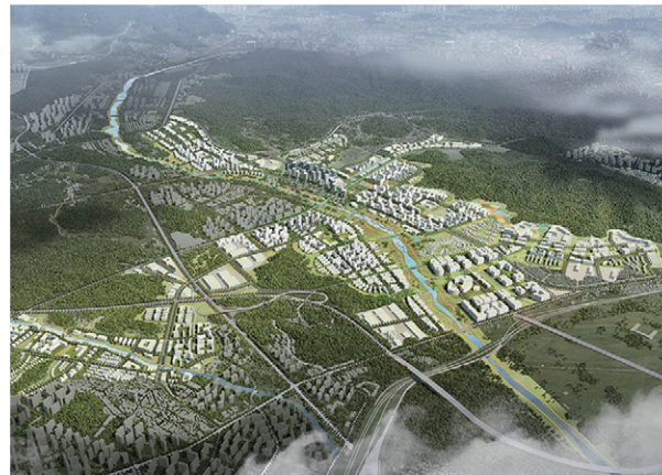
고양창릉 공공주택지구 조성공사(1공구) 2022.12~2028.09
