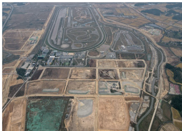
행정중심복합도시 6-4생활권 조성공사 2018.07~2023.12
