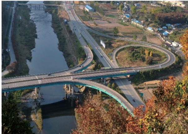
점촌-문경간 도로 4차선 확포장공사 1993.12~1999.12
