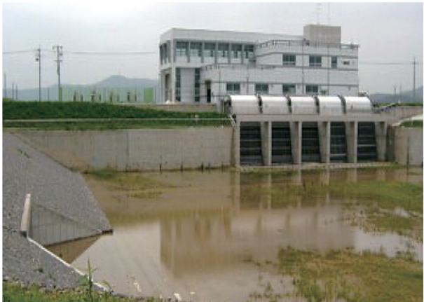
하빈 배수펌프장 설치공사 2004.03~2008.07
