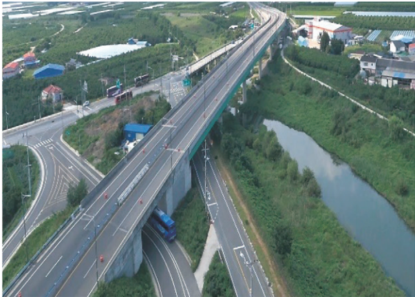
청도-경산간 도로 4차로 확포장공사 2004.04~2016.05
