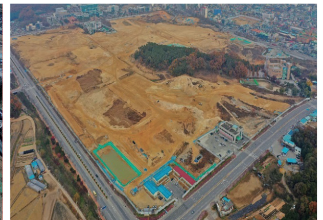
이천중리 택지개발사업 조성공사 2018.10~2022.12
