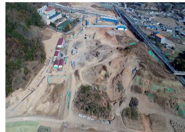
부산장안지구 택지개발사업(2단계) 조성공사 2018.08~2022.07
