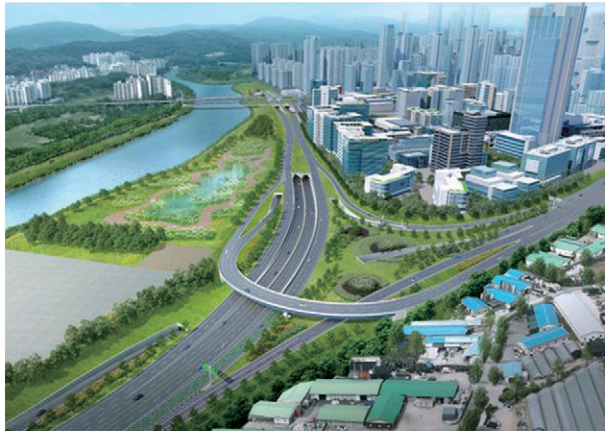
남양주왕숙 국도47호선 이설(지하화)공사 2023.12~2028.10
