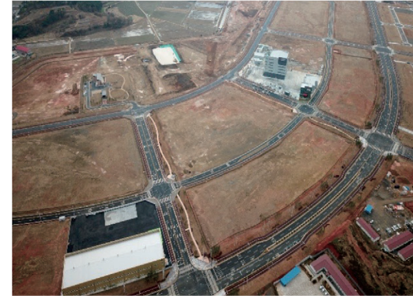
행정중심복합도시 6-4생활권 조성공사 2016.08~2022.06
