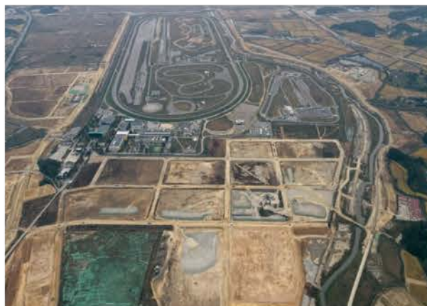
행정중심복합도시 6-4생활권 조성공사 2018.07~2023.12
