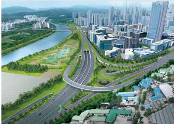
남양주왕숙 국도47호선 이설(지하화)공사 2023.12~2028.10
