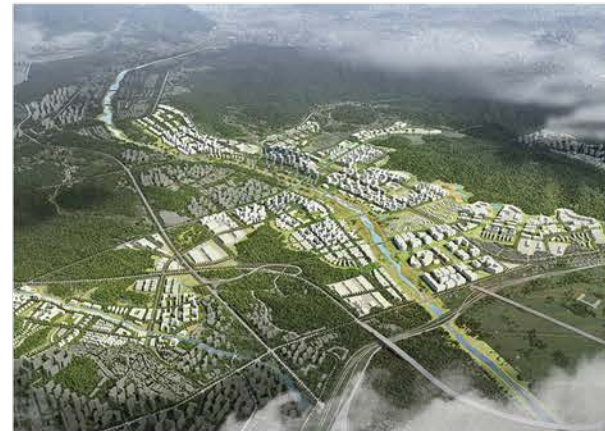
고양창릉 공공주택지구 조성공사(1공구) 2022.12~2028.09
