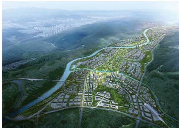
남양주왕숙 공공주택지구 조성공사(3공구) 2022.11~2028.06
