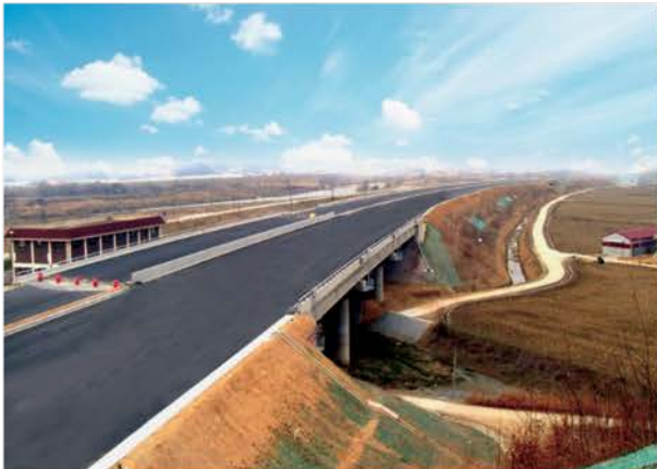
행복도시-고속철도 오송역 도로건설공사(1공구) 2008.12~2022.07
