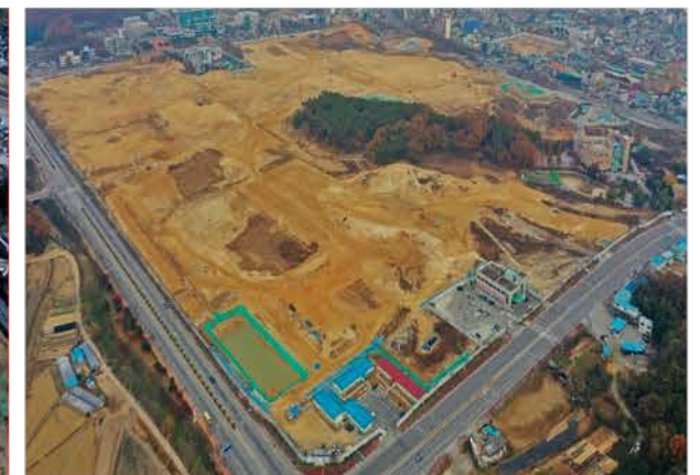
이천중리 택지개발사업 조성공사 2018.10~2022.12
