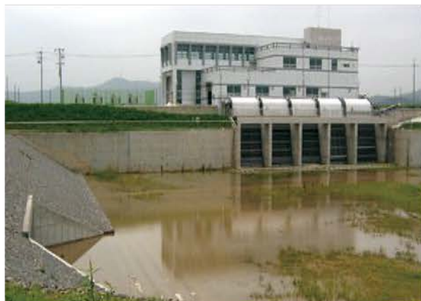
하빈 배수펌프장 설치공사 2004.03~2008.07
