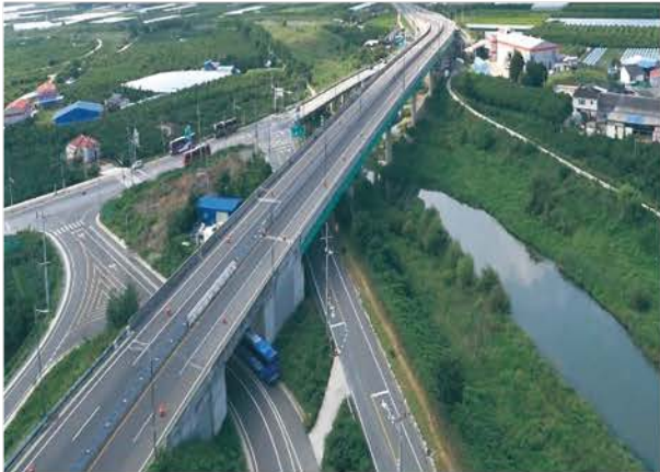
청도-경산간 도로 4차로 확포장공사 2004.04~2016.05
