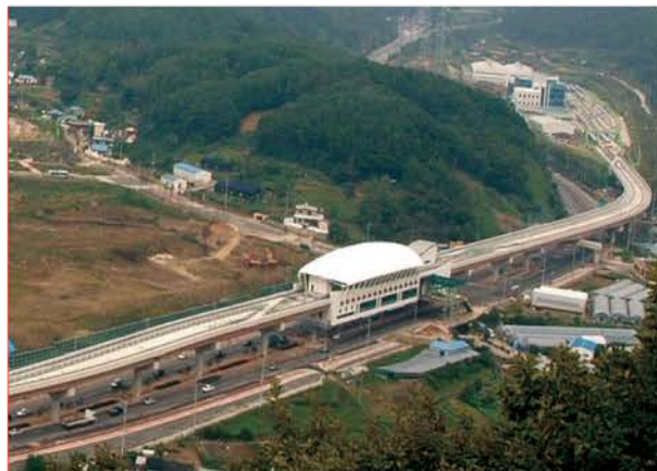
부산 3호선 2단계 328공구 토목공사 2004.04~2010.12
