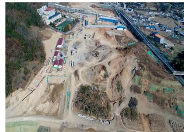
부산장안지구 택지개발사업(2단계) 조성공사 2018.08~2022.07
