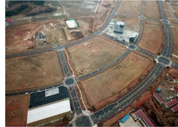
행정중심복합도시 6-4생활권 조성공사 2016.08~2022.06
