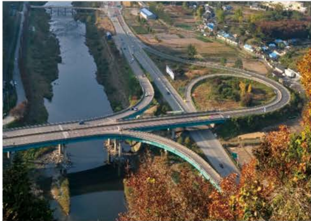
점촌-문경간 도로 4차선 확포장공사 1993.12~1999.12
